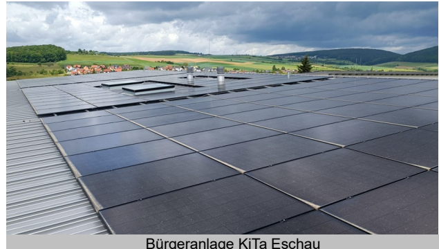
Bürgeranlage KiTa Eschau
